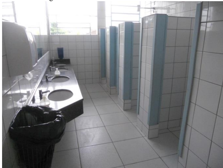
Figura 13 – Banheiro Masculino e Feminino.
