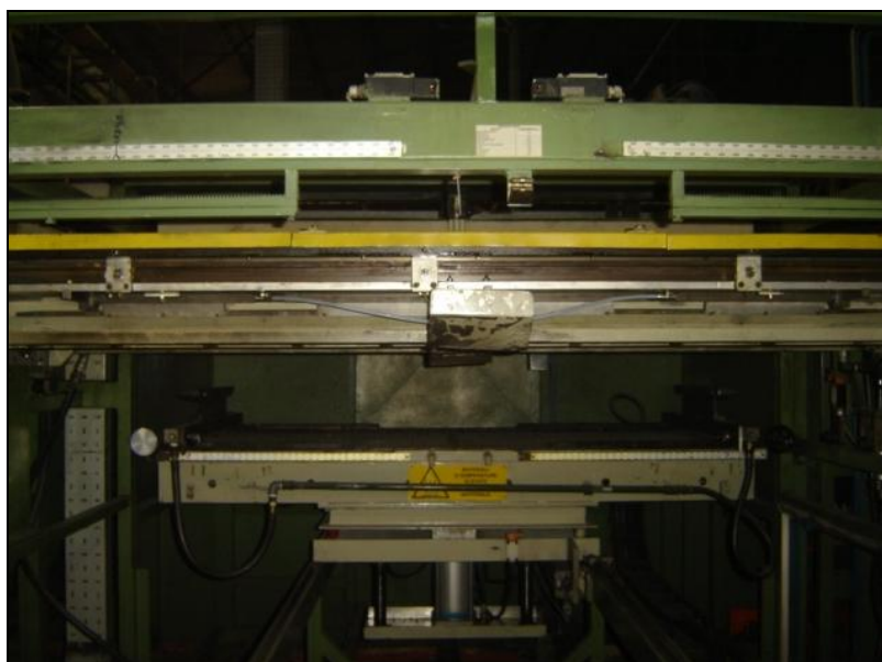
Figura 5 – Sistema de aquecimento de chapas na termoformadora.
