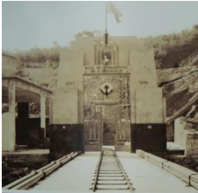
Figura 10 – Prtico da base durante o seu funcionamento.
