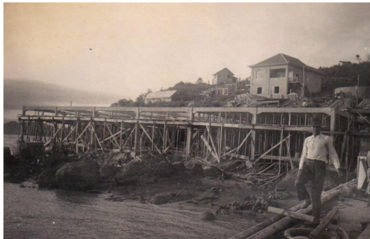
Figura 14 – Estrutura do alojamento e do depósito de carvão.
