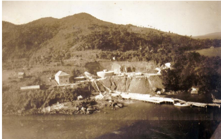
Figura 13 – Vista das obras em estágio mais avançado.
