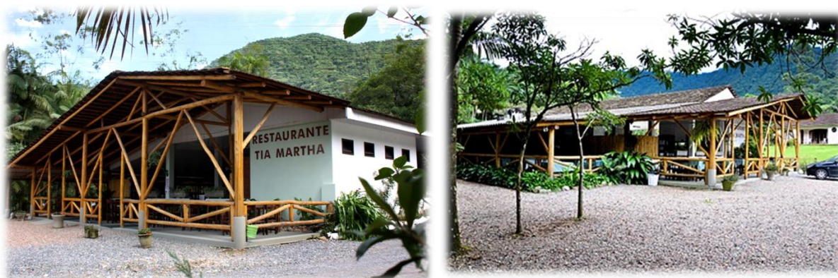
Figura 26 - Fachada do Restaurante Tia Marta - 2012
