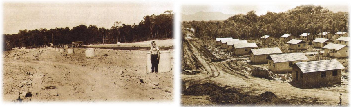
Figura 15 - Construção do Comasa no bairro Boa Vista - 1960 e 1969
