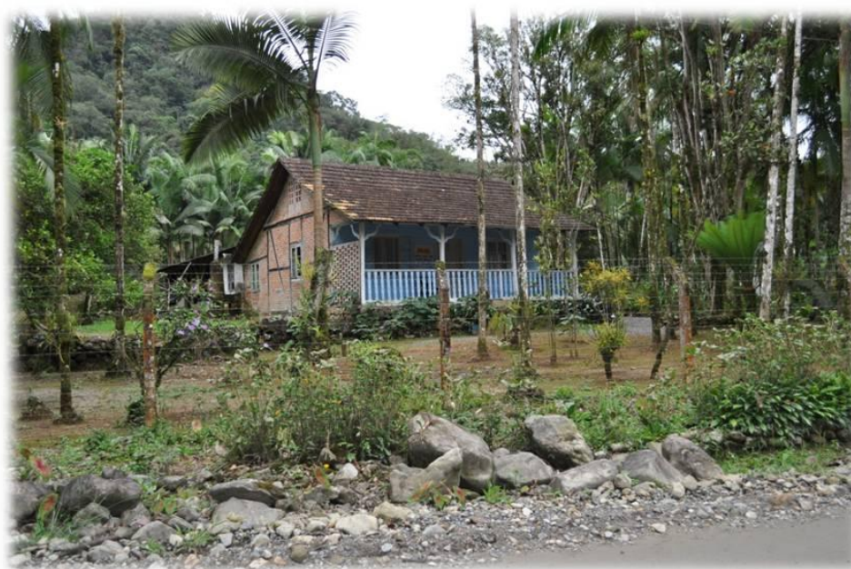
Figura 28 - Casa em estilo enxaimel (construção localizada na Estrada Bonita - Joinville/SC) - 2012
