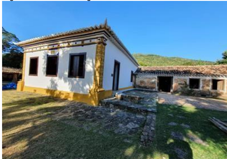
Figura 38 – Casarão Engenho dos Andrades
