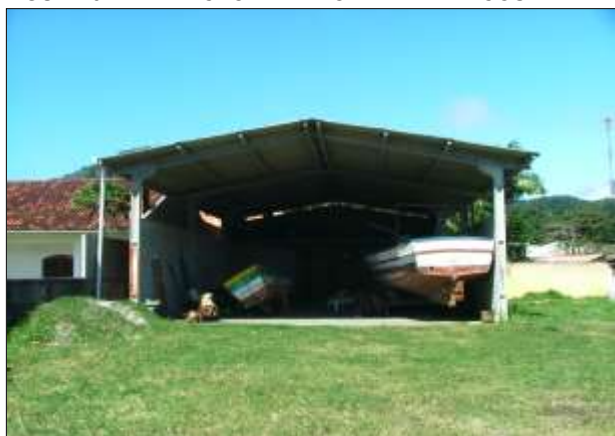
FIGURA 02- BARRACÃO DE REFORMA DE BARCOS
